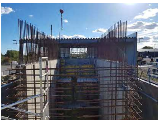
Tillbyggnaden är i full gång på Stengårdens avloppsreningsverk.
